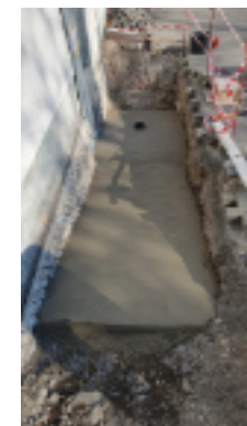
Knochenarbeit für den neuen Notausgang zum Parkplatz hin.
